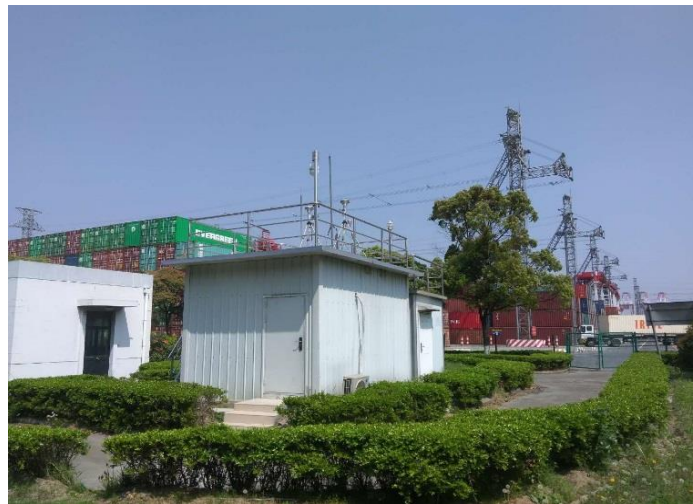
外高桥二号码头站
